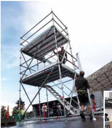
Snabbast och säkrast. Jubileumsfestens ställningsbyggartävling gick ut på att bygga en Layher Allroundställning med två bomlag, utanpåliggande trappa och mätten 2,57 x 1,40.
