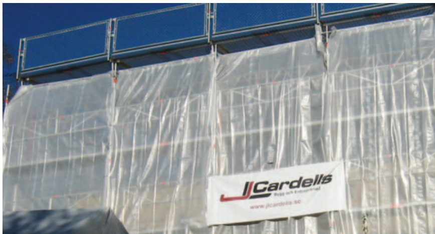
► Väl inklätt och skyddat av de patenterade plastkassetterna blir huset högre. Ramställning i aluminium skymtar bakom.
